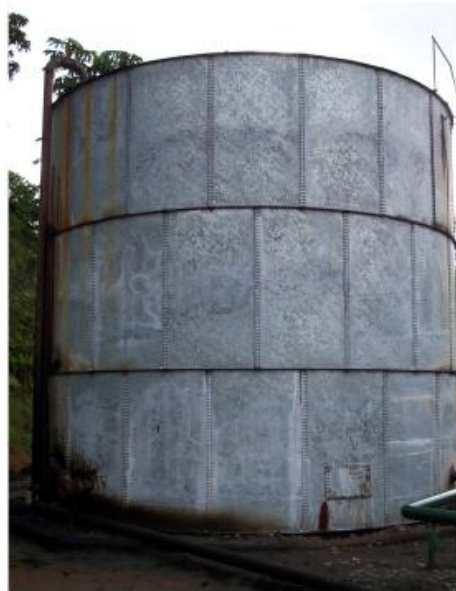
Gráfico 2-13 Tanques empernados
