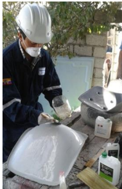
Primera capa de resina epoxi.
