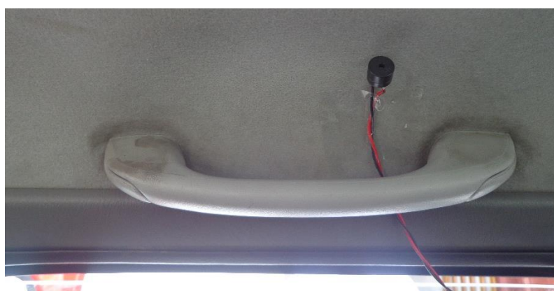
Fig. 4.34 Instalación del zumbador Fuente: Investigador
