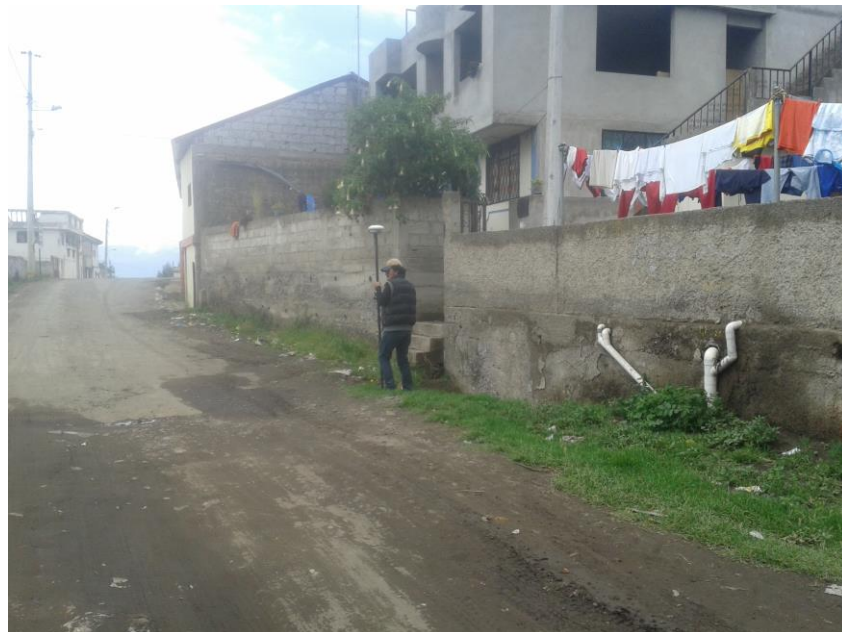
Foto 8. Viviendas que no cuentan con una red de alcantarillado
