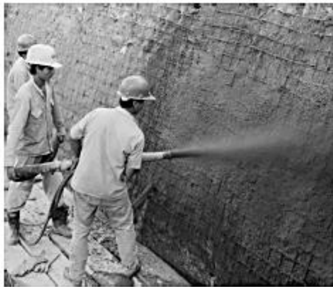
Figura 2.3 Muros Anclado de Hormigón Proyectado
