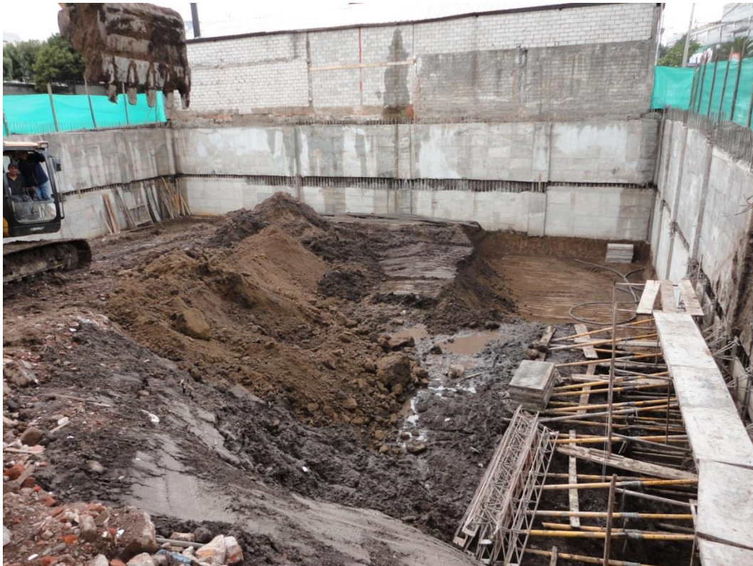
Figura 2.15 Fotografía de la aplicación de muros anclados en la construcción de subsuelos de un edificio en la ciudad de Quito.
