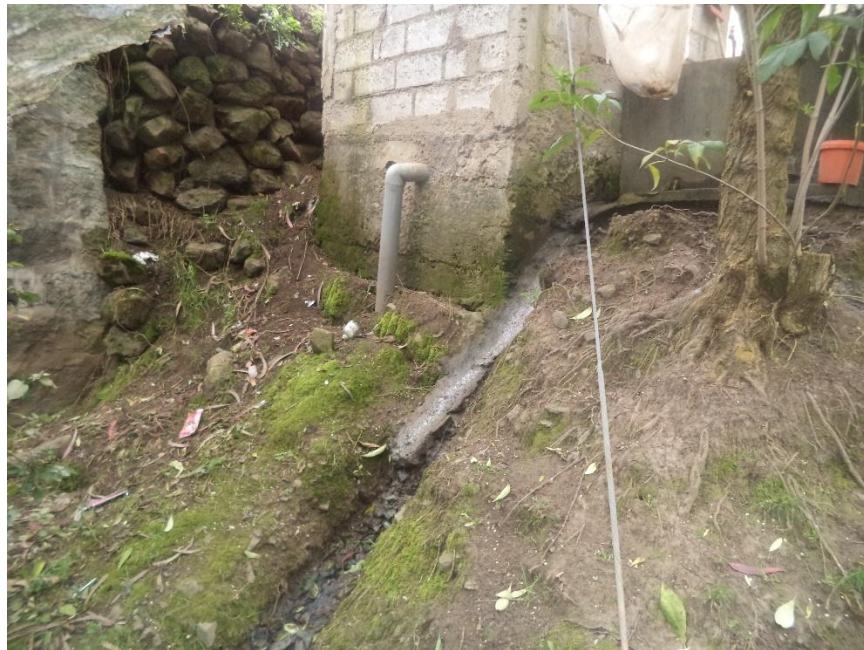
Base de una Letrina en una de las viviendas del Sector
