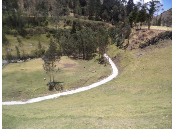
Ilustración 29. Canal de acceso a la planta de Energía Eléctrica.
