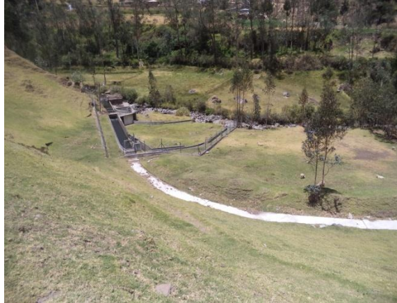
Ilustración 28. Canal de acceso a la planta de Energía Eléctrica
