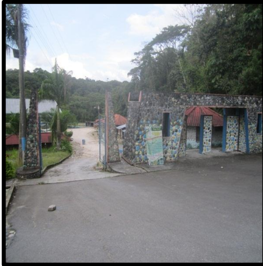
Ingreso al Dique de Mera
