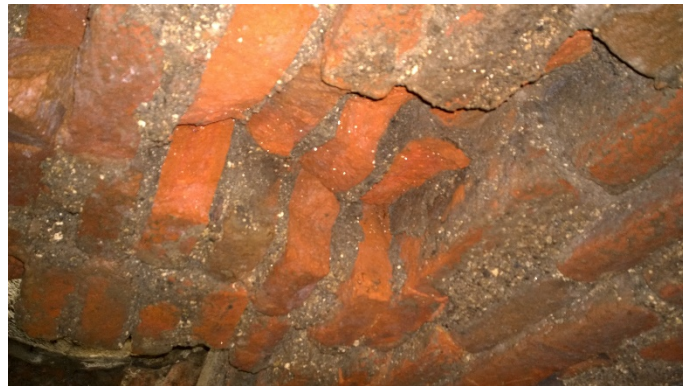
Ilustración 4: Ladrillo desgastado
