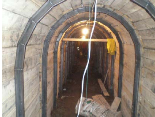
Ilustración 36: Cerchas metálicas con entibado de madera
