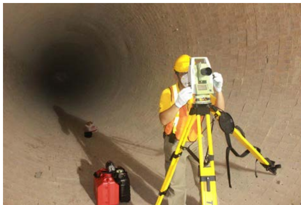
Ilustración 27: Levantamiento subterráneo con estación total
