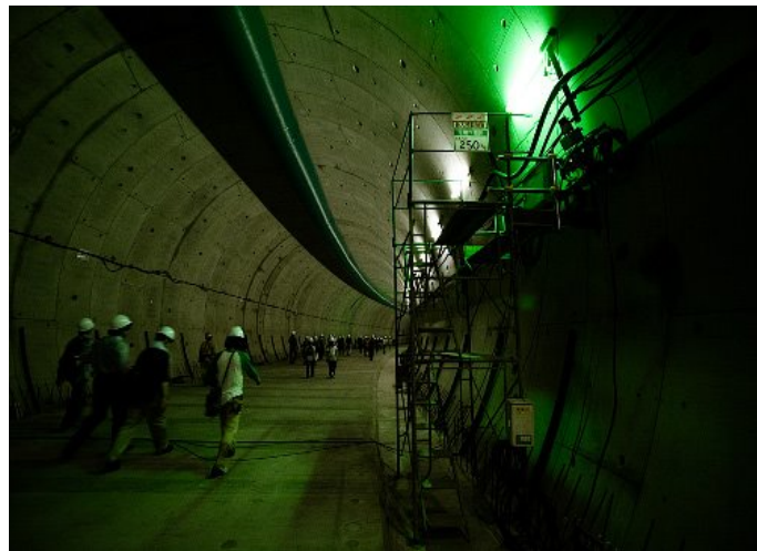
Ilustración 23: Túnel de conducción G-Cans Project
