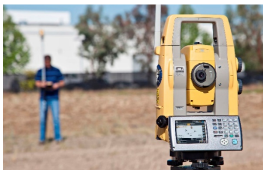
Ilustración 25: Levantamiento topográfico con Estación Total
