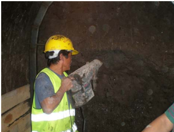
Ilustración 33: Perforación con rotomartillo
