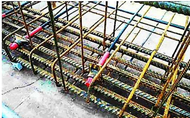
Imagen 3. Detallado y armado de bandas de anclajes
