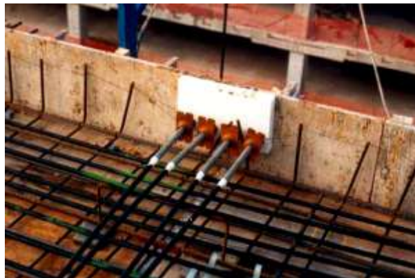
Imagen 5. Protección de anclajes antes del hormigonado
