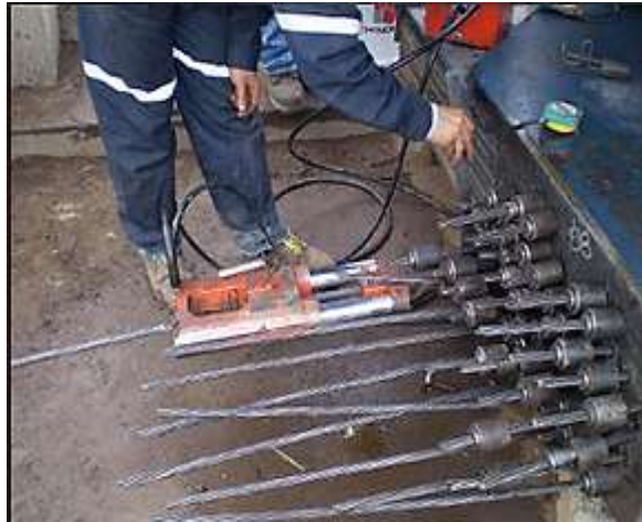
Imagen 1. Tensado de los cables después del fraguado
