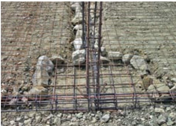
Plintos o zapatas y contrapisos en viviendas
