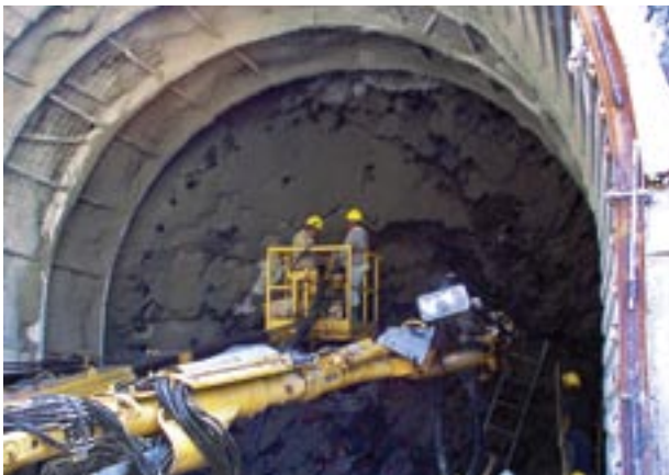
Reforzamiento de túneles
