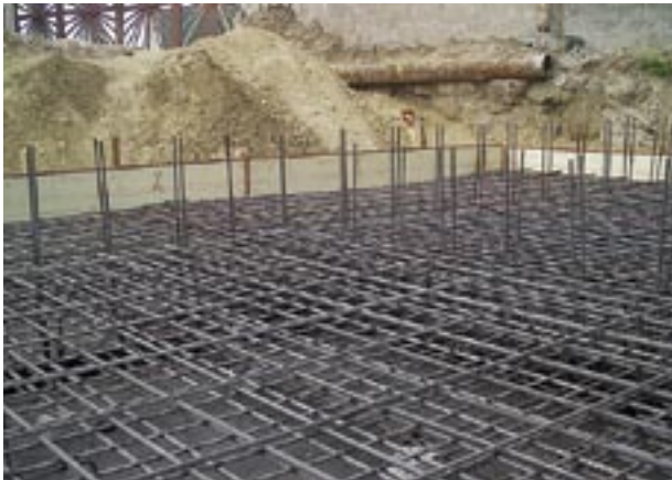
Losas de cimentaciones
