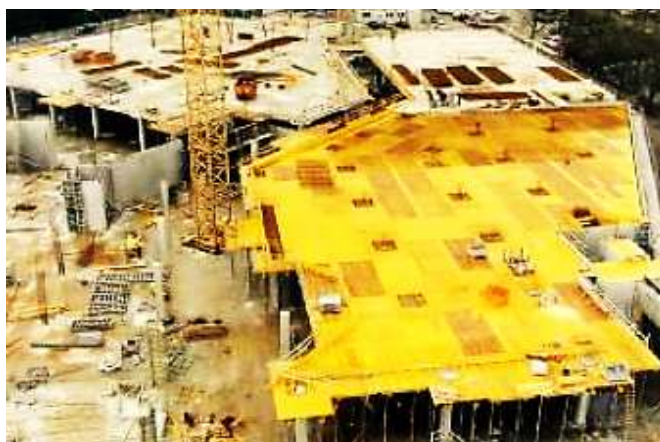
Imagen 4. Encofrado tradicional para losas
