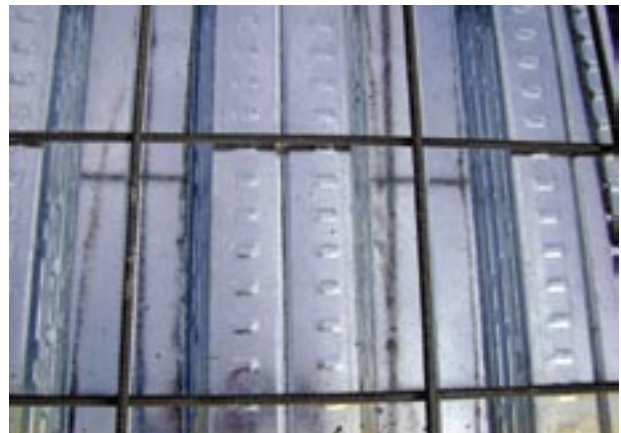
Refuerzo sobre láminas metálicas colaborantes
