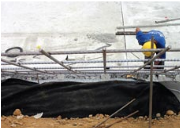
Muros y estructuras de contención
