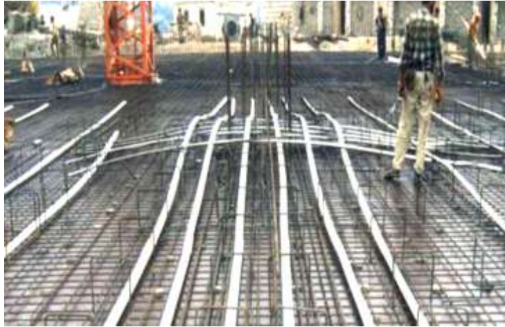
Imagen 2. Detallado y armado de un capitel de columna
