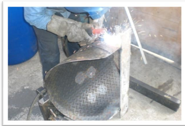
Fig. 6.32. Soldadura del eje con la virola.
