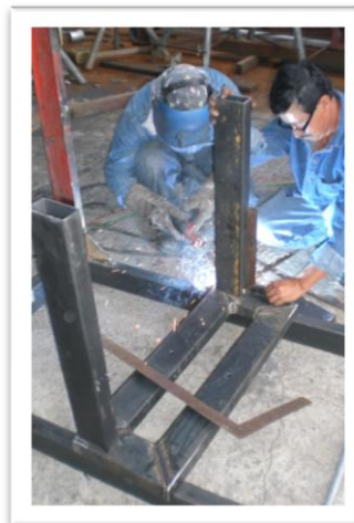
Fig. 6.25. Soldadura del Cuadrante y Horquillas.
