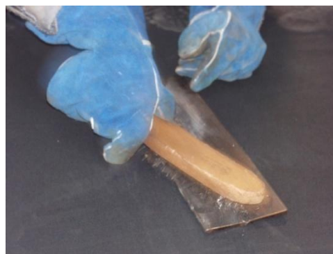
Gráfico 22. Limpieza del cordón de soldadura
