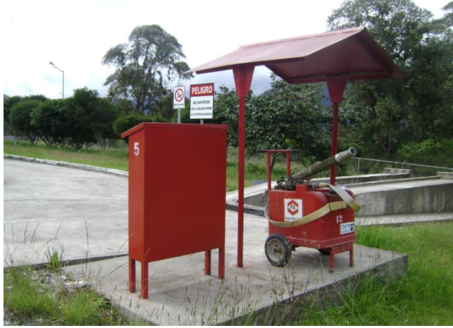
Foto N° 2.7: Equipos de seguridad contra incendios
