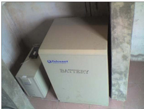
Figura 6.17: Baterías de respaldo de energía
