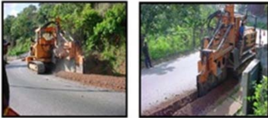
Figura 2.22.- Máquina zanjadora de disco
