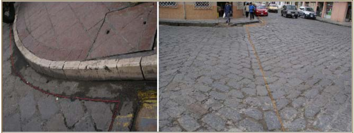
Figura 6.34: Microzanjado
