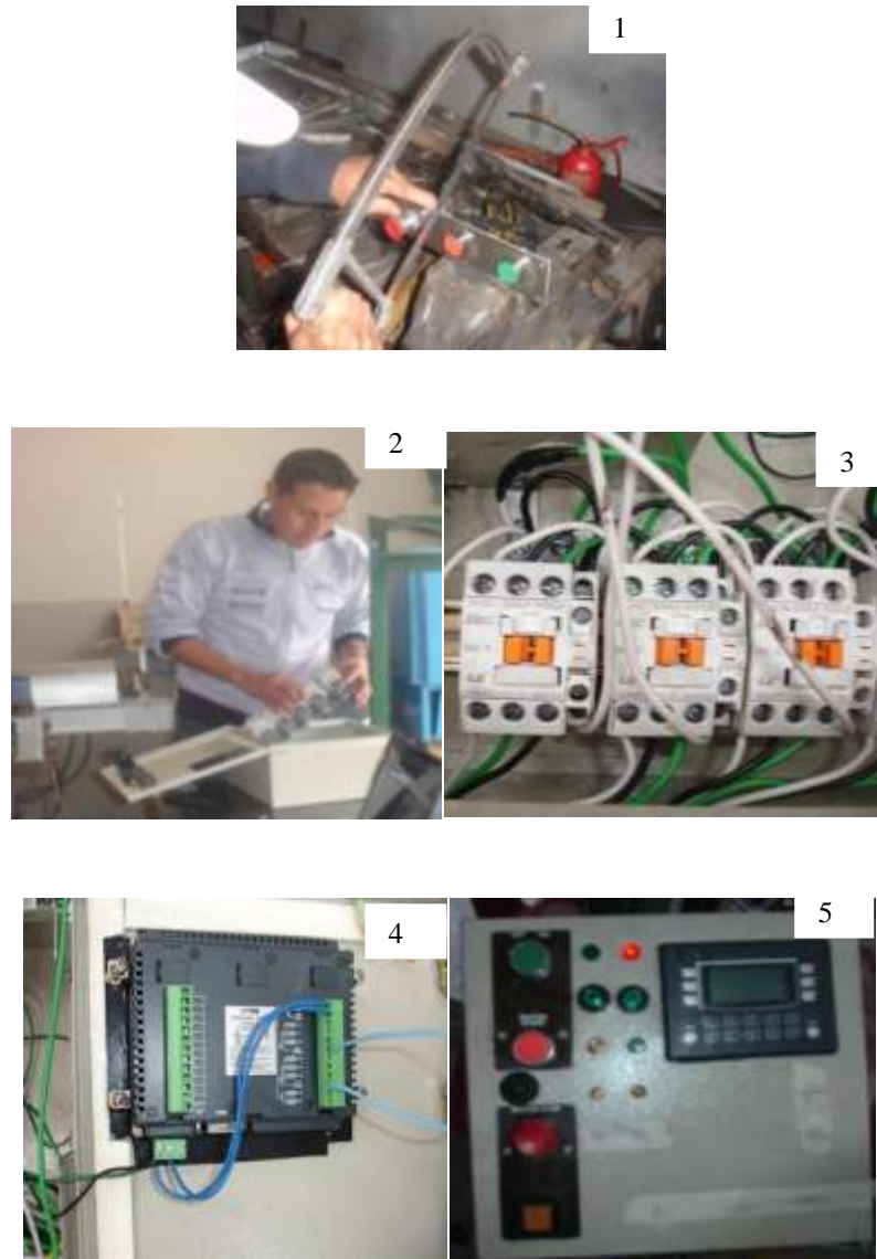
Figura. 6.17 Construcción del tablero de control
