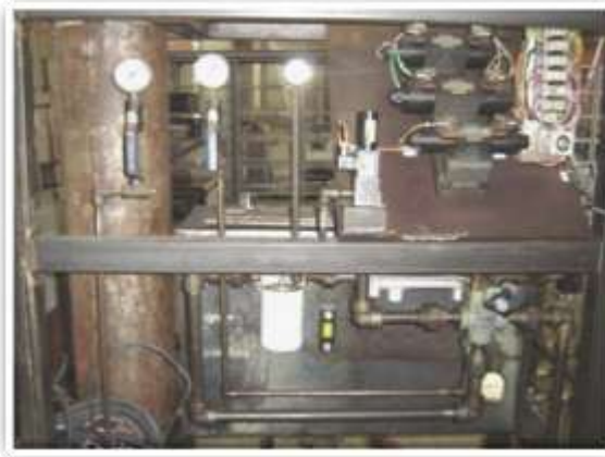
Figura 2.12 Unidad motriz de la inyectora.
