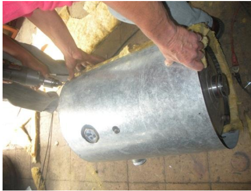
FIGURA 10.- COLOCACION DE LA LANA DE VIDRIO
