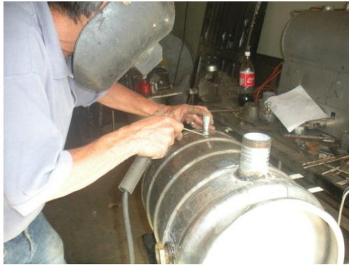
FIGURA 7.- COLOCACION DEL MANÓMETRO DE PRESIÓN
