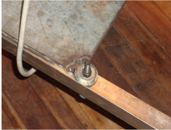
IMAGEN 6.9.- UBICACIÓN DE LOS PERNOS PARA SUJETAR LA PLANCHA DE TOL
