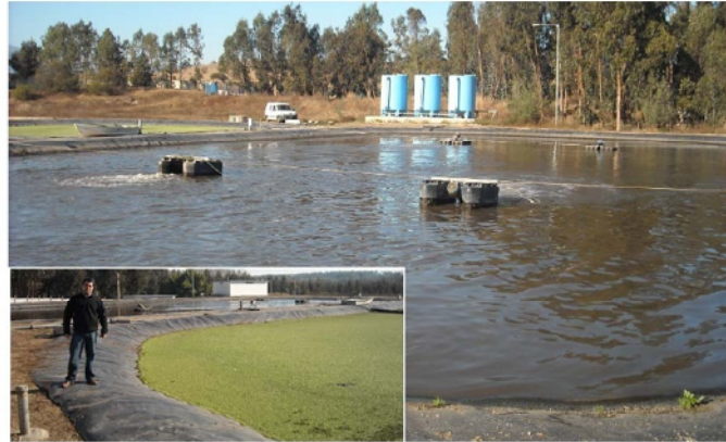
Figura 5. Lagunas de Estabilización, mezcla completa
