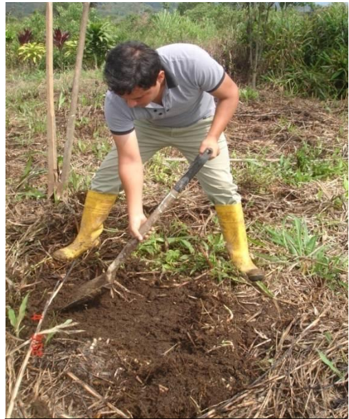
Foto 2. Inicio de excavación
