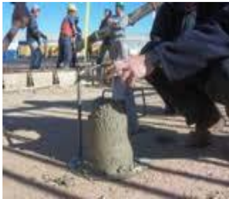
Fotografía.VI.6.6.6. Ensayo de asentamiento
