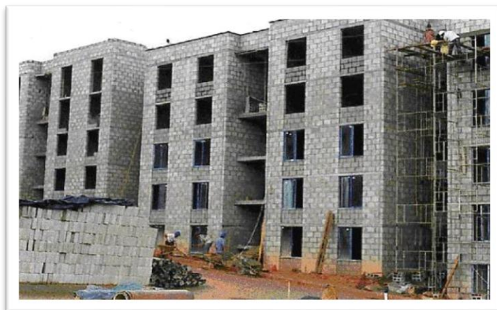
Fig.II.4 Edificio multifamiliar en Mampostería reforzada
