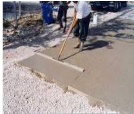
Fotografía.VI.6.6.7. Alisado de hormigón con Aditivos
