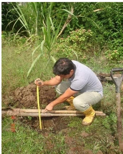
Foto 3. Aparición de agua (nivel freático)
