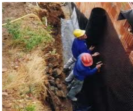
Fotografía.VI.6.6.3. Instalación de barrera contra la humedad
