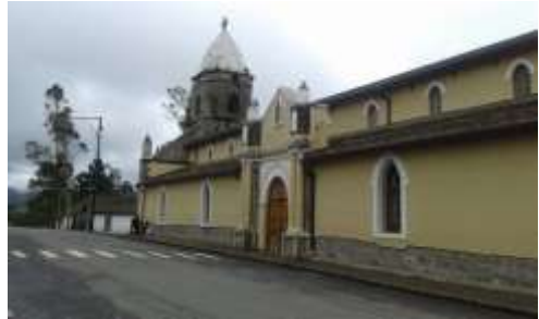
Fotografía 8: Fachada de la Iglesia San Lucas
