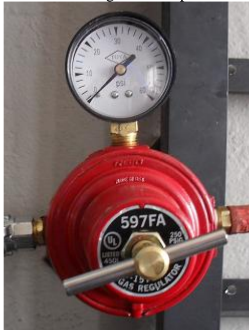
FIGURA 6-13: Regulador de presión de gas
