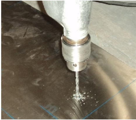
Imagen 6.3.-Perforacion para el interruptor
