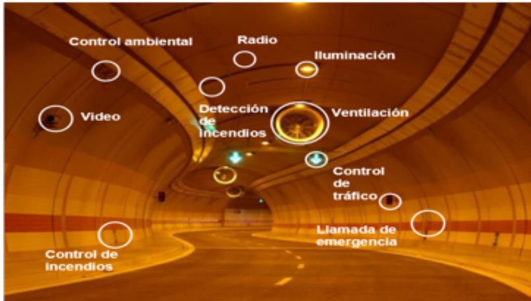
Figura 2.22: Iluminación eficiente en túneles [29].
