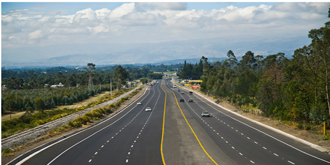
Figura 2.19: Tramo de la autopista Jambelí – Latacunga – Ambato [26].
