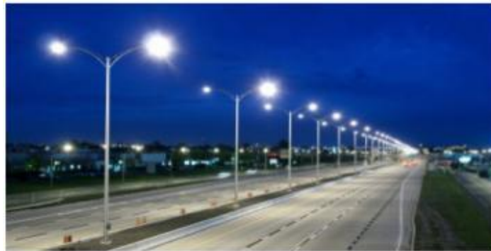
Figura 3. Sistema de iluminación en autopistas (Alzubaidi & Soori, 2012).
