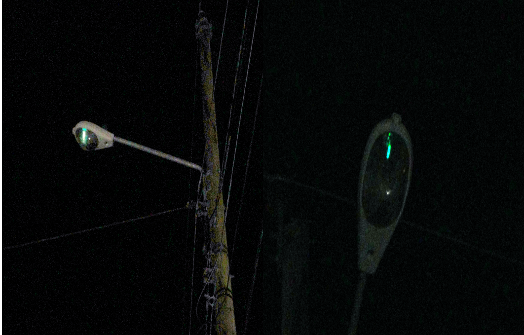
Figura 2.61: Luminarias deficientes en el alumbrado público [fuente propia]
