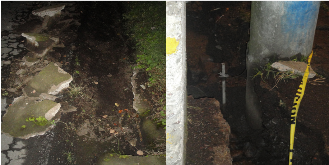
Figura 2.64: Excavaciones y tomas a tierra en alumbrado público [fuente propia]
