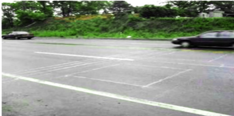
Figura 2.69: Manguera Neumática en Carretera [58]
