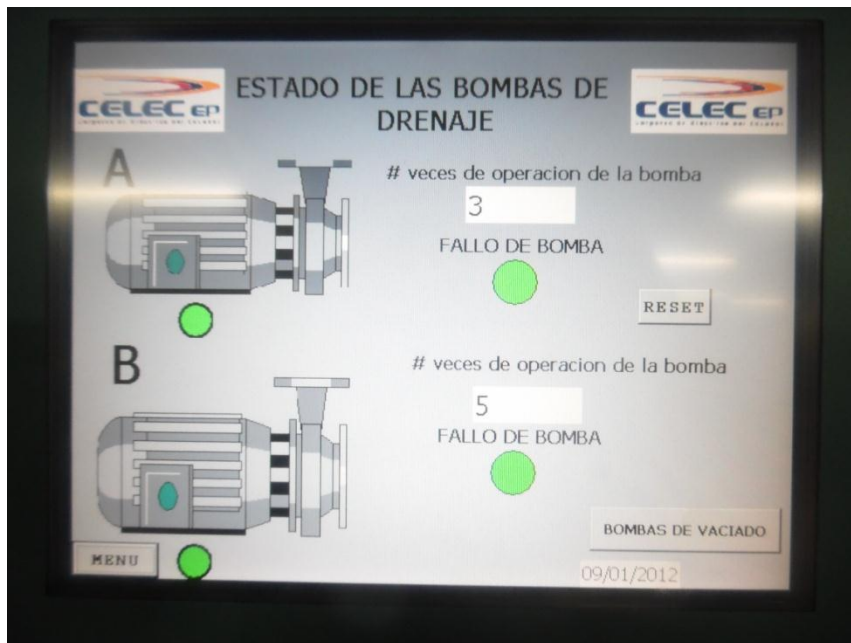
Figura 4.76: Pantalla para visualizar el estado de las bombas de drenaje.
