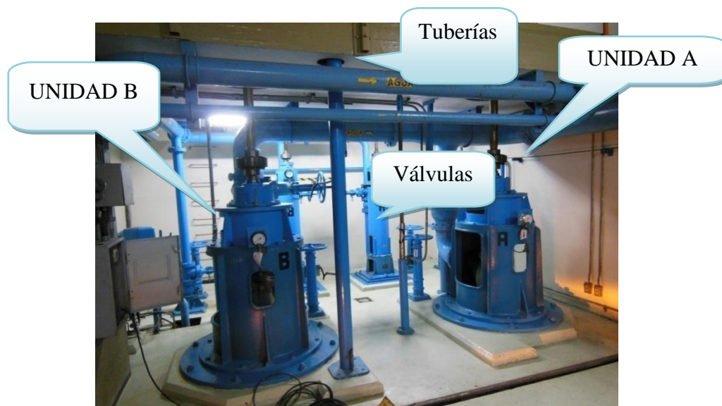
Figura 4.84: Sistema de drenaje.
