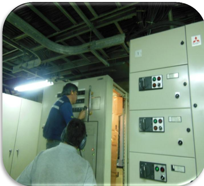
Figura 4.47: Perforación de la cavidad para la HMI.
