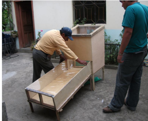
Fotografía No.5: Construcción del secador solar mixto (unido colector de calor con cámara de secado).
