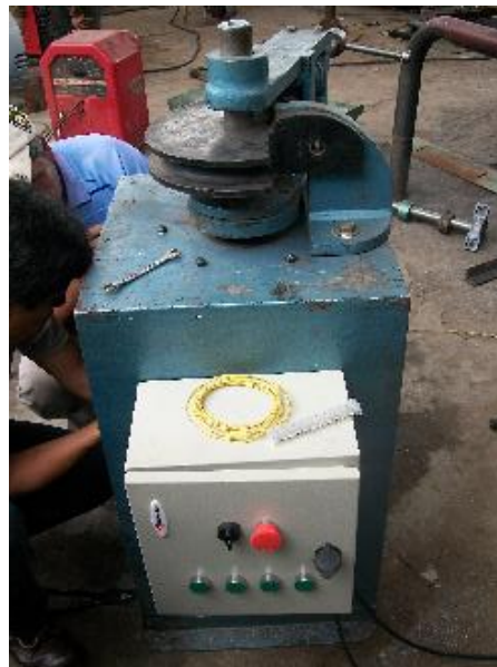
Figura 6.11 Colocación del gabinete eléctrico Fuente: Autor
