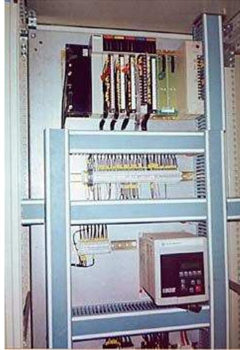
Tablero de control con PLCs y controles de velocidad de frecuencia variable.
