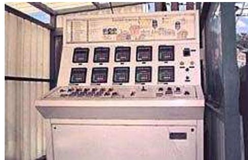
Tablero tipo consola, con semigráfico para planta de tratamiento de aguas de proceso.
