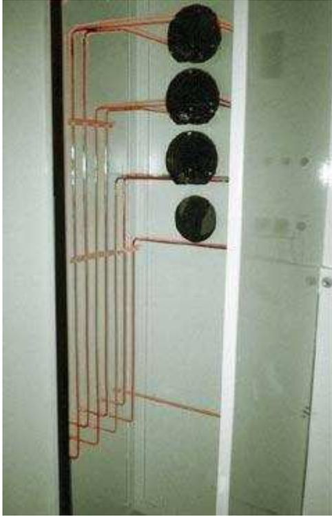
Detalle de tubería / tubing en cobre de ¼ pulgada.
