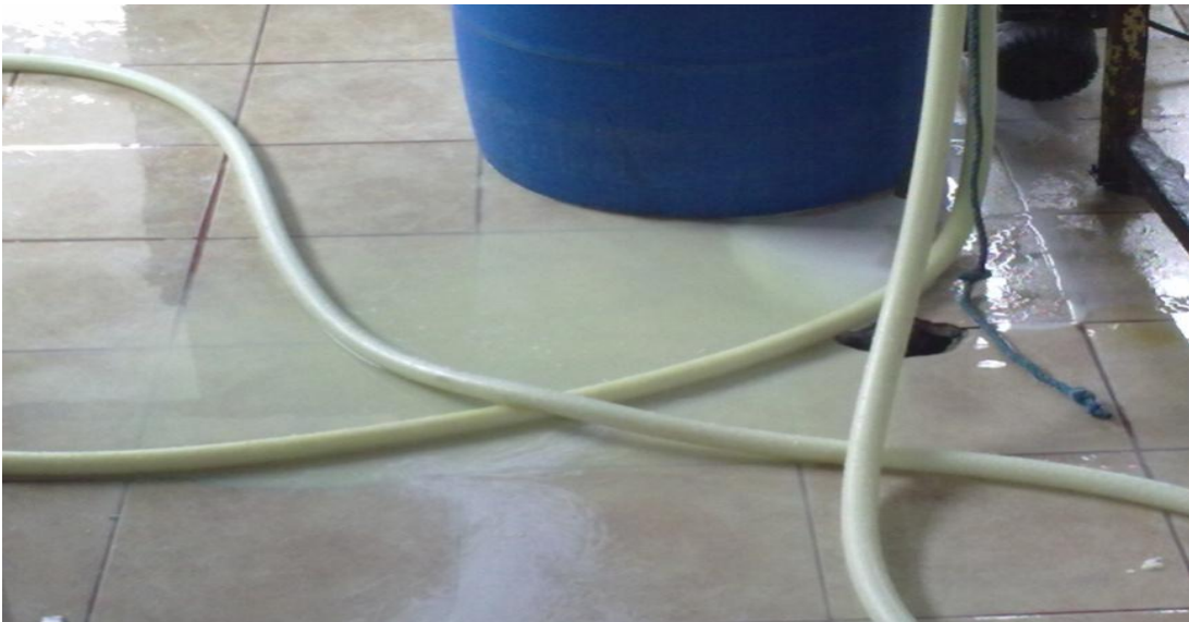
Figura N° 22 Suero derramado y vertido por los drenajes
