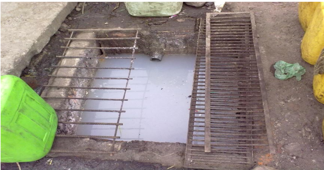
Figura N° 28 Pozo de revisión en las afueras de la Quesería
