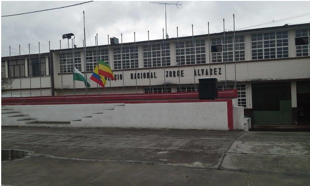
Foto N°1: Instalaciones de la institución
