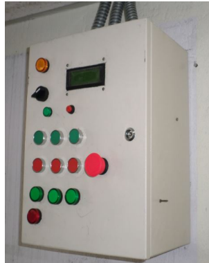
Figura 55: Montaje del tablero de control.
