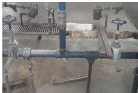
Figura 16: Válvulas de compuerta.
