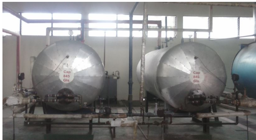
Figura 5: Sistema de recirculación de agua caliente.
