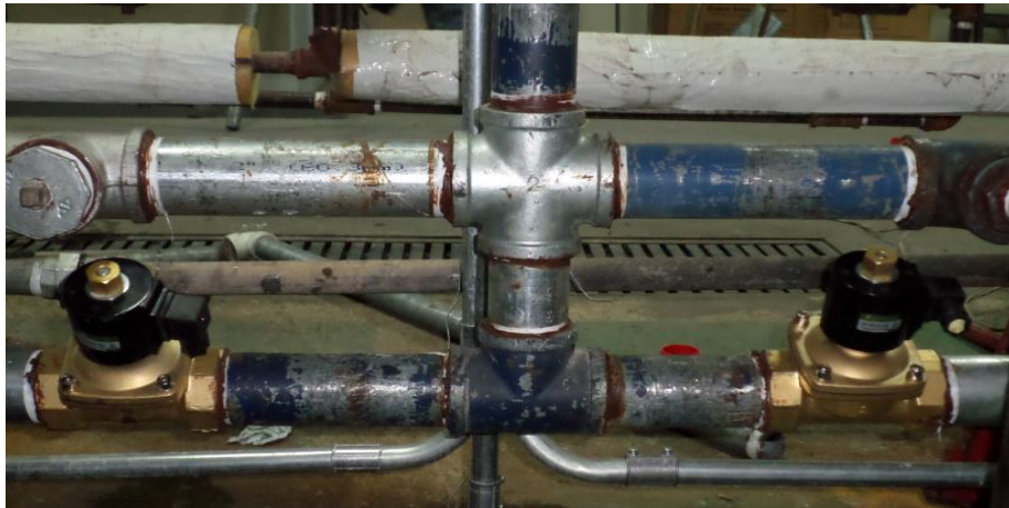
Figura 54: Instalación de las válvulas solenoides.
