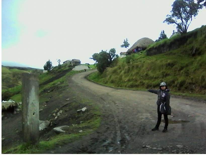
Estado actual de la vía km 0+000
