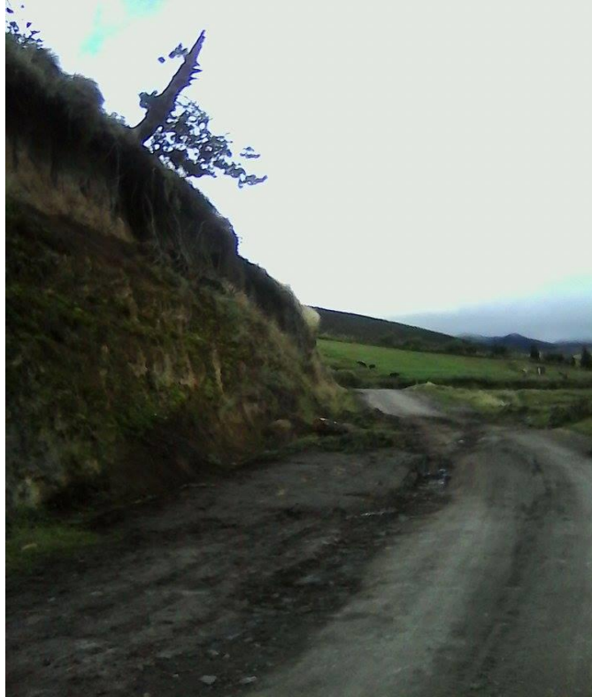
Estado actual de la vía km 2+300: descenso de material y lastrado malo
