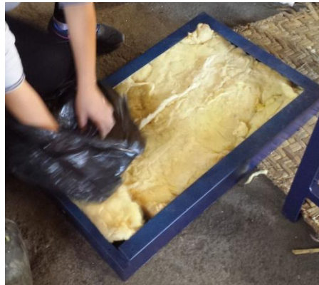
Figura 6.26 Colocación del aislante térmico en la pared de la cámara
