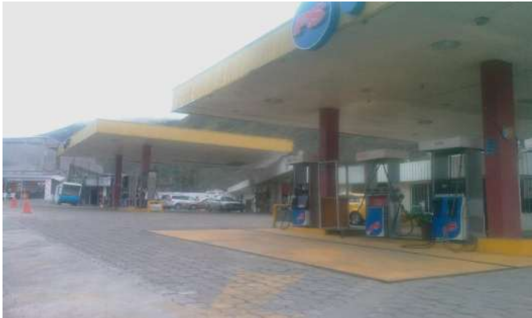
Foto N# 4: Área de Estacionamiento y comercialización
