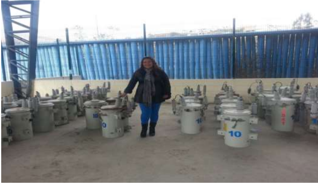
Transformadores monofásicos con calificación 6
