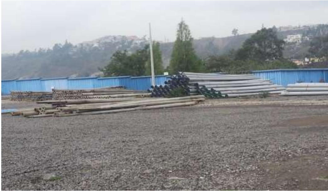
Postes de hormigón
