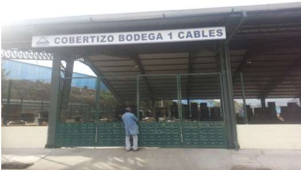
Bodega 1 Cables y Accesorios
