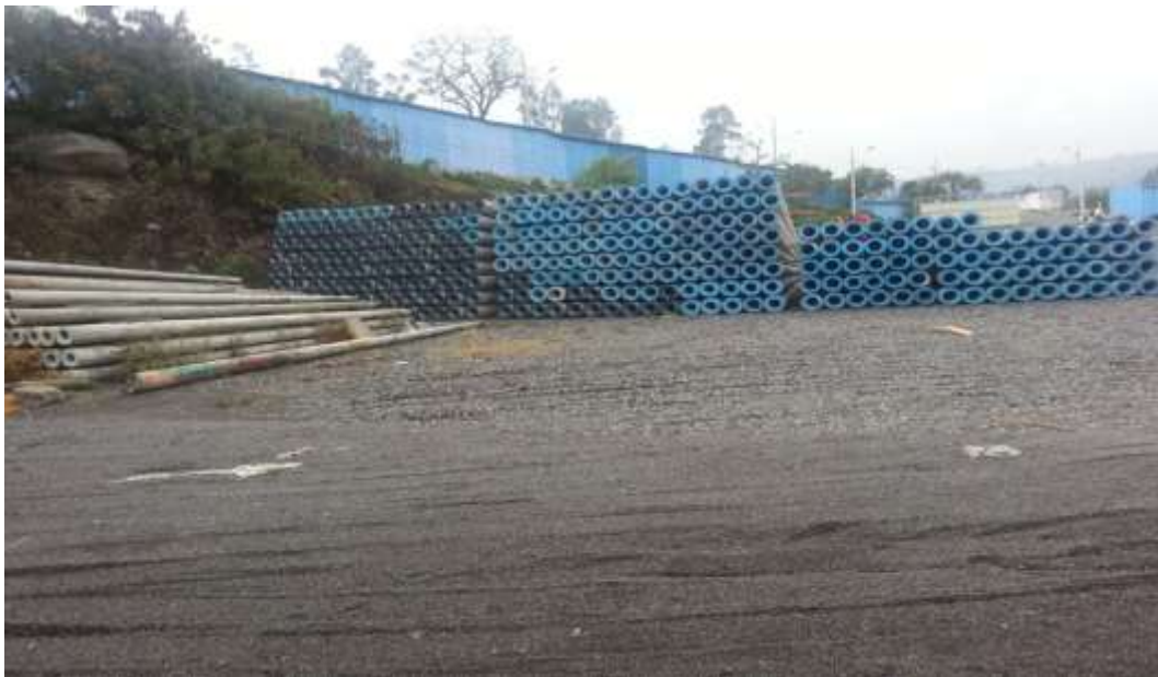
Postes de hormigón
