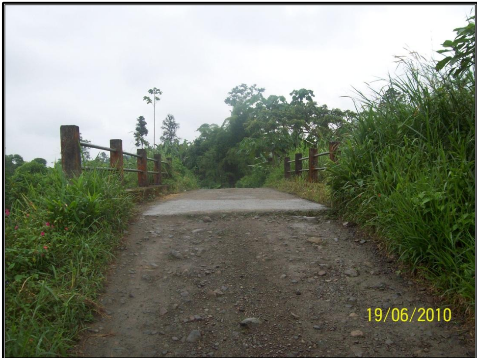
Foto 8. Puente de Hormigón Armado Abcisa 3 + 180
