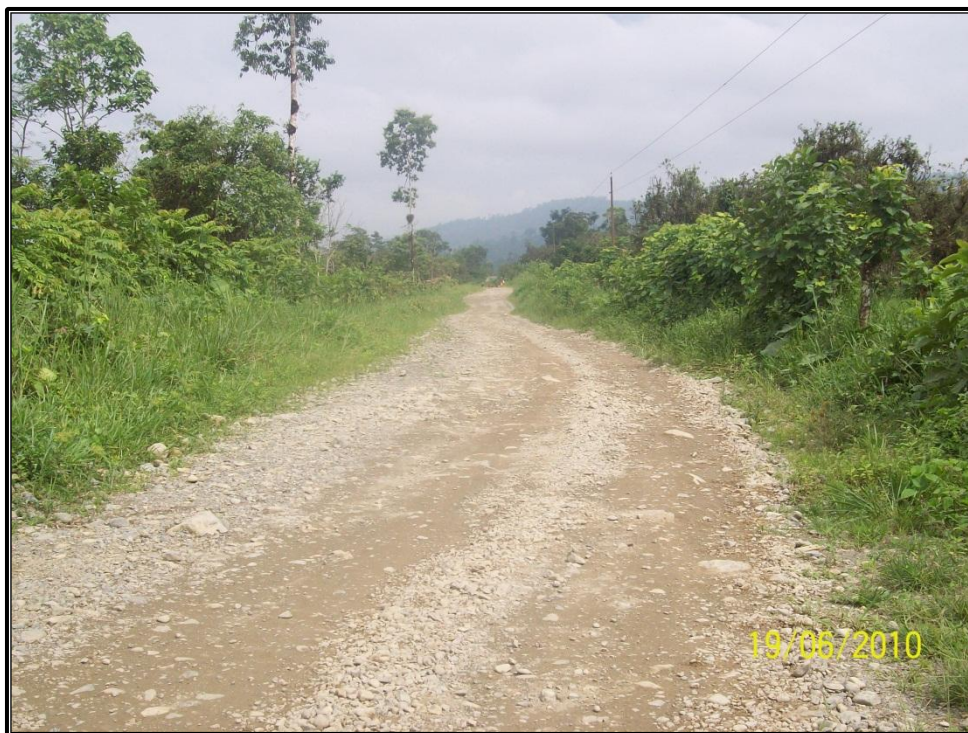
Foto2. Pendiente natural de la vía
