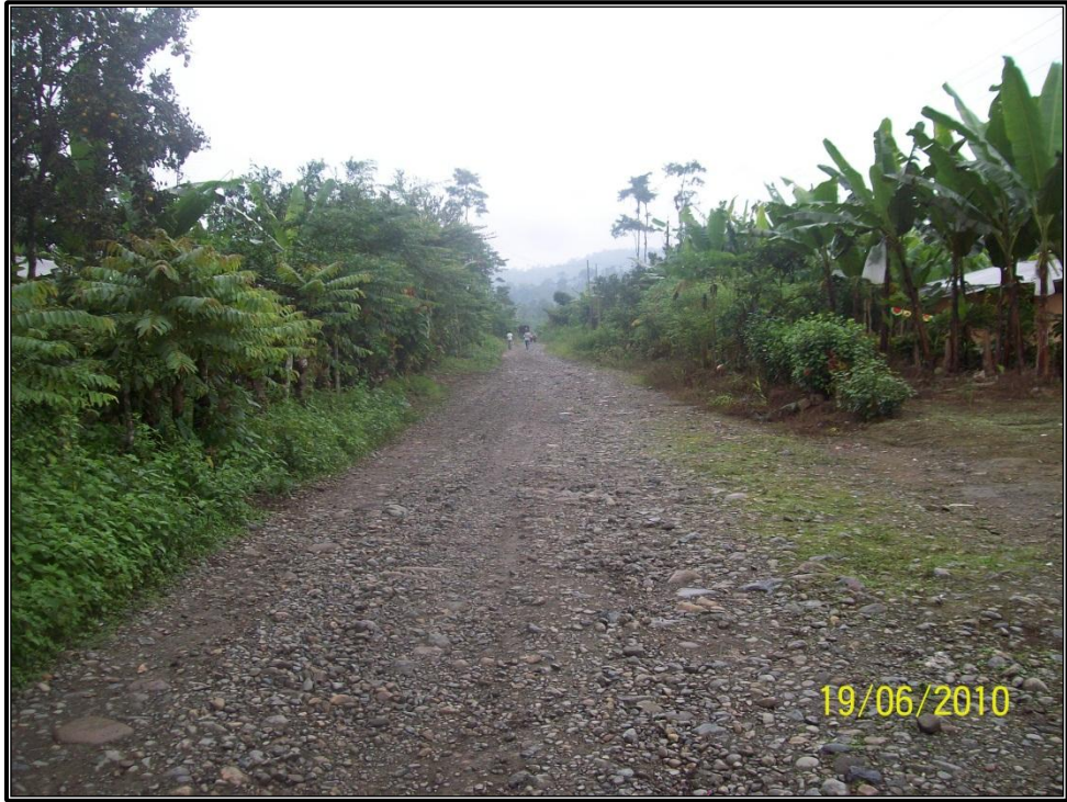
Foto 7. Capa de rodadura lastrada
