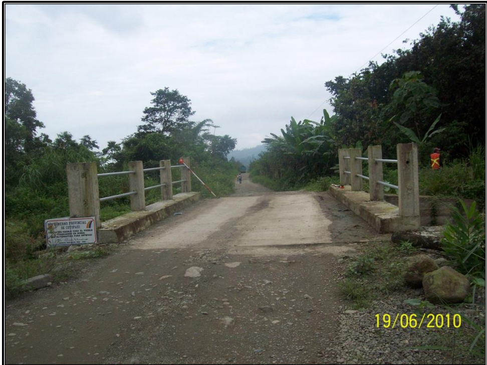
Foto4. Puente nuevo de Hormigón Armado Abscisa 1 + 400
