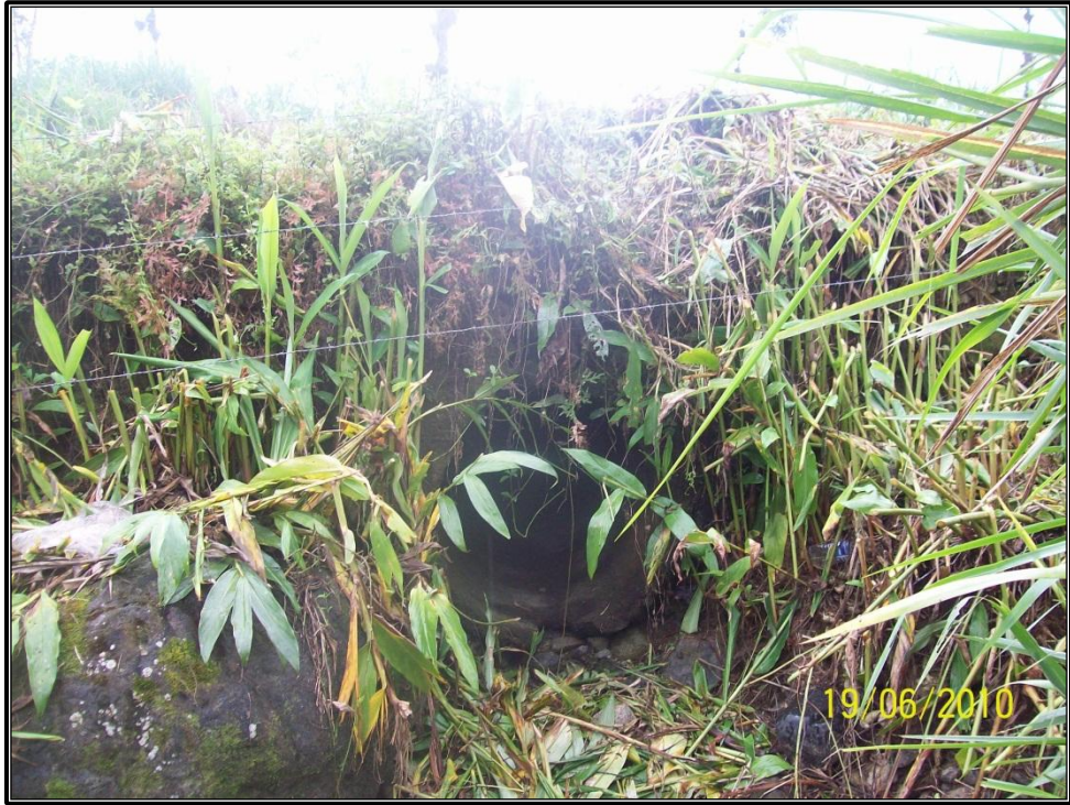
Foto3. Pasos de agua existentes a lo largo de la vía
