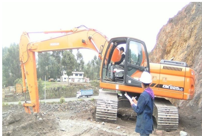
Figura.4.15: Aplicación de la técnica del cuestionario (Operador de Excavadora).
