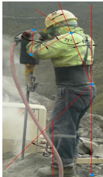
Figura.4.12: Análisis de la operación o manipulación de la máquina para perforación de piedra.
