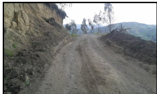
Capa totalmente al suelo natural
