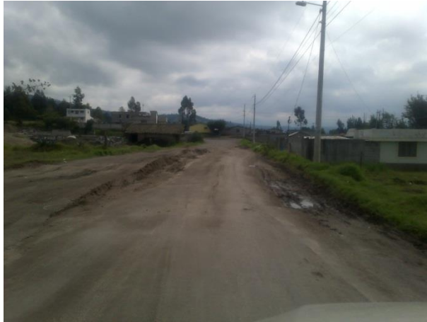
Estado actual de la vía del proyecto existente.
