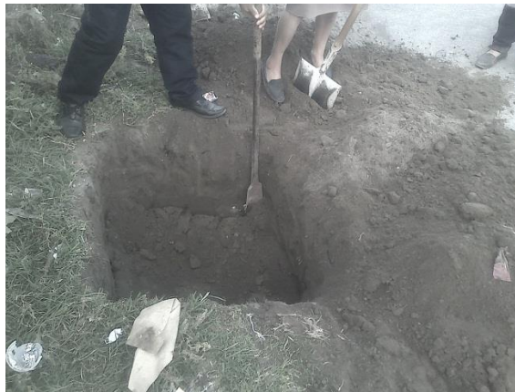
Calicata a cielo abierto
