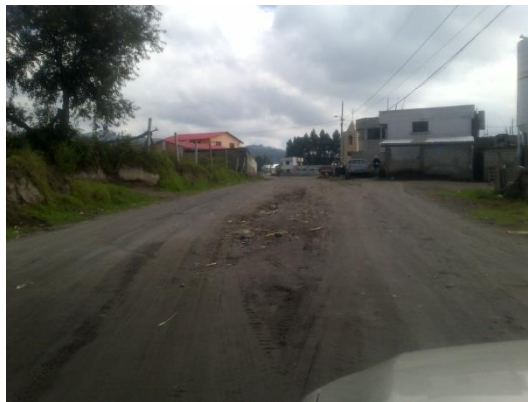
Estado actual de la vía del proyecto existente.
