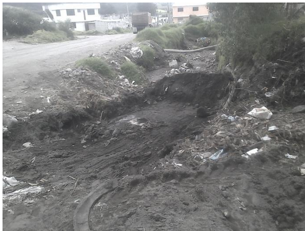
Evidencia del mal estado de la vía existente.
