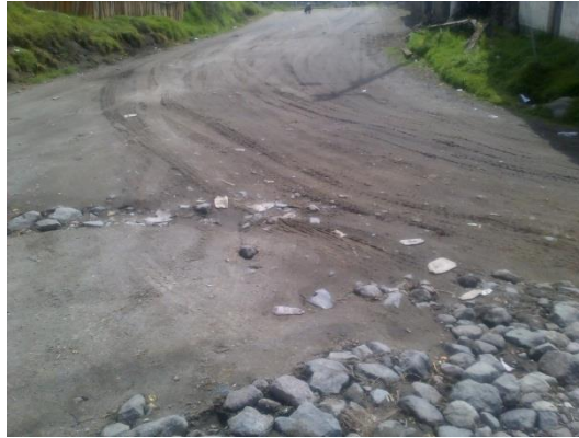
Estado de la vía existente en el inicio.
