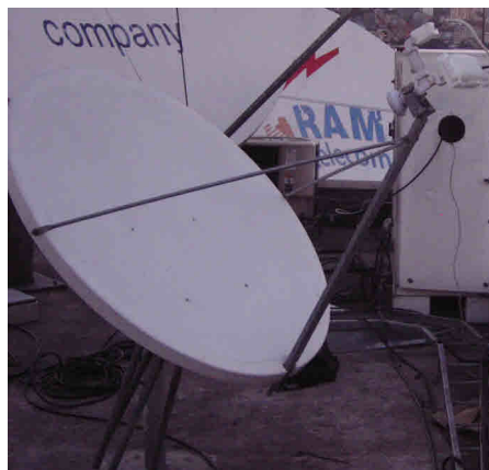
Figura 4.4 Instalada para la Implementación de las Redes
