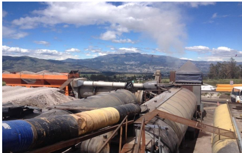
Fotografía 4 Planta de producción en general
