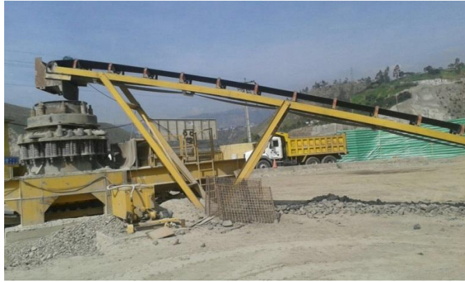
Fotografía 3 Banda de transportación de piedra hacia la máquina de trituración
