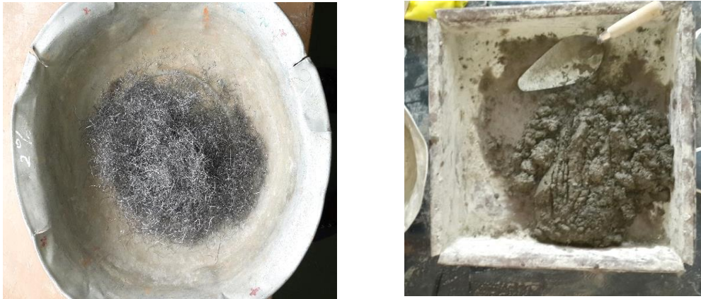
Imagen No.11 Mezcla del Mortero con Fibra de Acero
