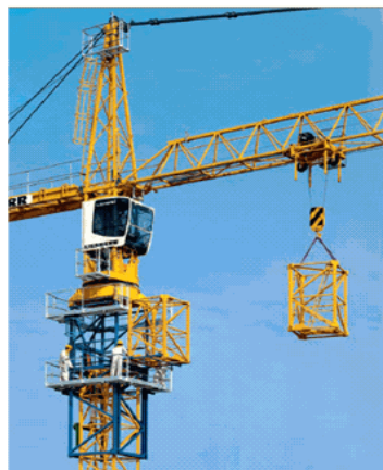
Figura 2-8 Grúa de Torre
