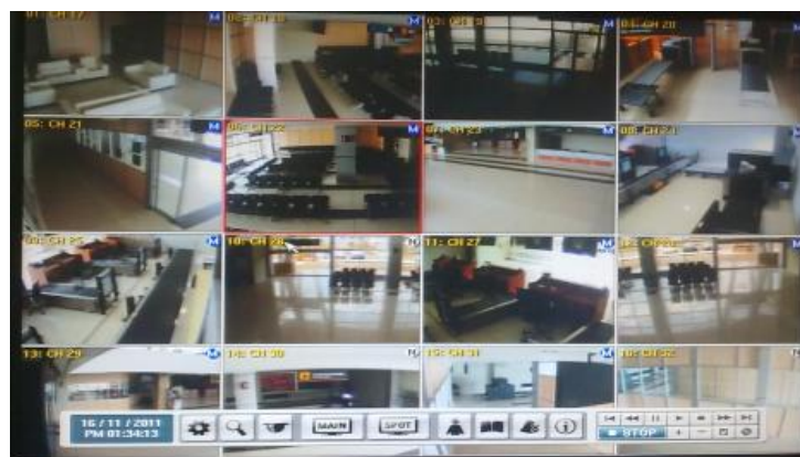
Figura No 52. Visualización de 16 Cámaras en el Aeropuerto.
