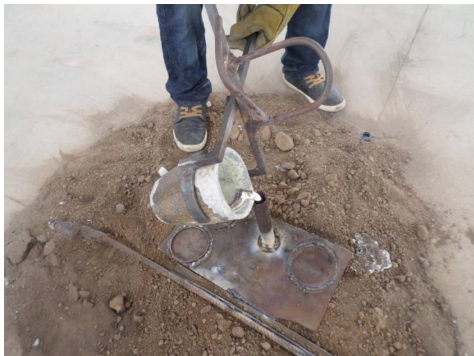
Figura 6-8 Verter la colada en el tubo
