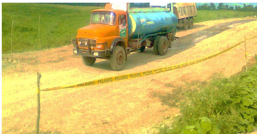
Fotografía. 15 Regado del aditivo TerraSil con el camión cisterna.
