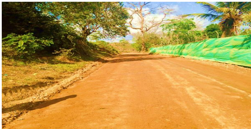
Fotografía. 18 Vía después del tratamiento con Aditivo Terrasil
