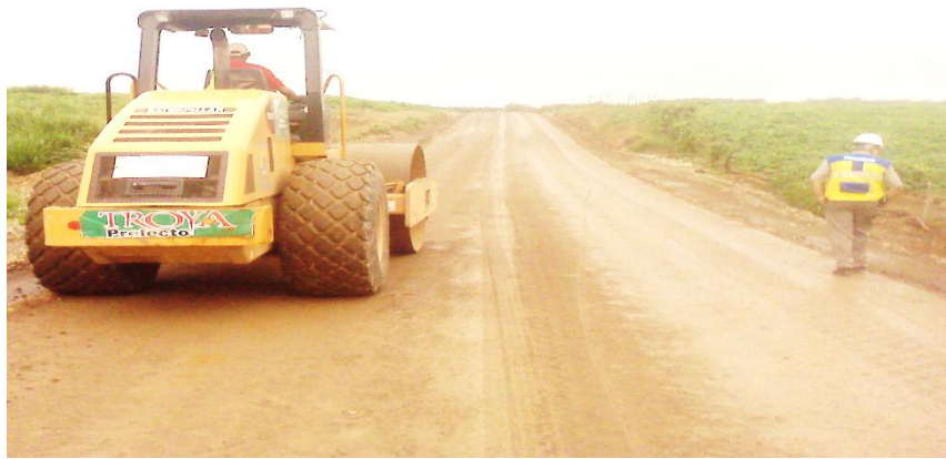
Fotografía. 16 Compactación del suelo con el rodillo liso vibratorio
