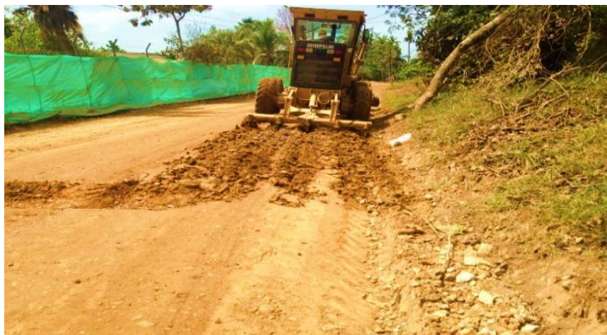
Fotografía. 14 Escarificación de la Sub base con motoniveladora.
