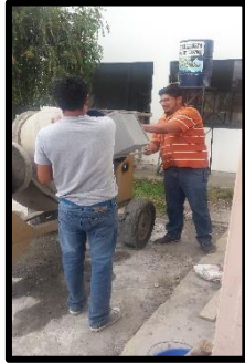
Agregados en la concreteira
