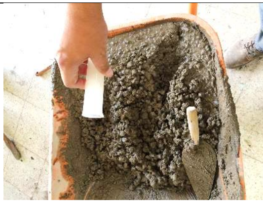
FOTO 2. ADICIÓN ADITIVO IMPERMEABILIZANTE
