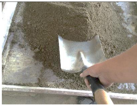
FOTO 4. MEZCLADO DE PROPORCIONES DE MATERIALES
