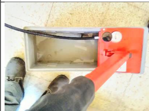
FOTO 3.- PRESURIZACIÓN DEL SISTEMA, BOMBA MANUAL
