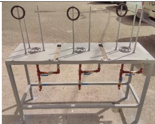
FOTO 17. PINTURA DE ACABADO ANTI-ÓXIDO GALBANIZANTE EN FRÍO.
