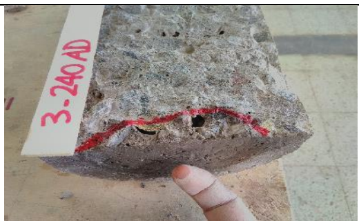
FOTO 11.- MUESTRA RESISTENCIA 240kg/cm CON ADICIÓN DE ADITIVO IMPERMEABILIZANTE CON EVIDENTE MUESTRA DE REPULSIÓN DE AGUA EN LA SUPERFICIE DE CONTACTO
