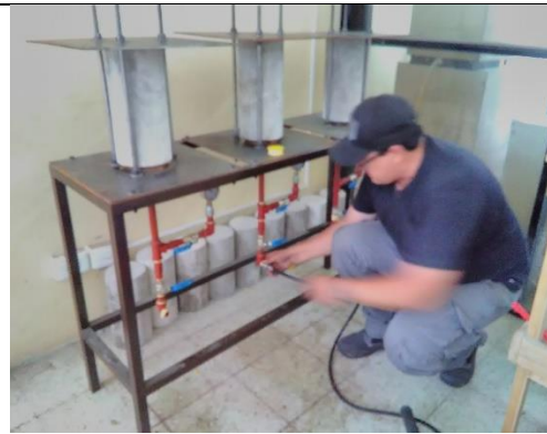
FOTO 16. PRESURIZACIÓN DEL SISTEMA
