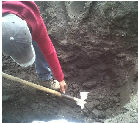
Excavación de la calicata
