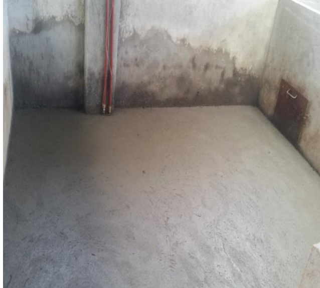
Figura 3. 42 Piso completamente terminado
