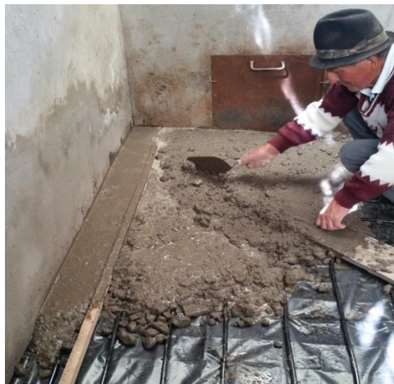
Figura 3. 41 Tendido y nivelado del mortero
