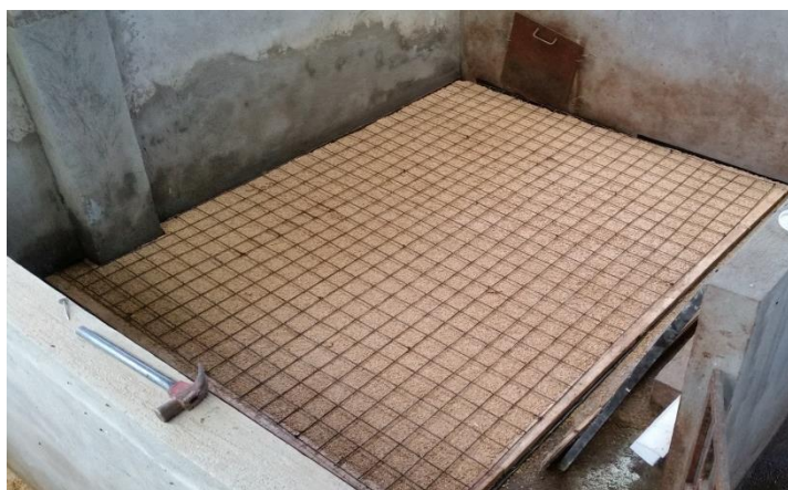
Figura 3. 25 Malla de acero Electro soldada sobre lámina de aislamiento
