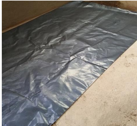
Figura 3. 19 Tendido de lámina de polietileno
