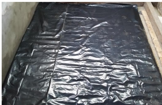
Figura 3. 27 Lámina de polietileno tendida sobre malla electro soldada
