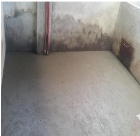
Figura 4 piso radiante terminado
