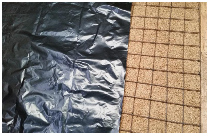
Figura 3. 26 Lámina de polietileno y malla electro soldada
