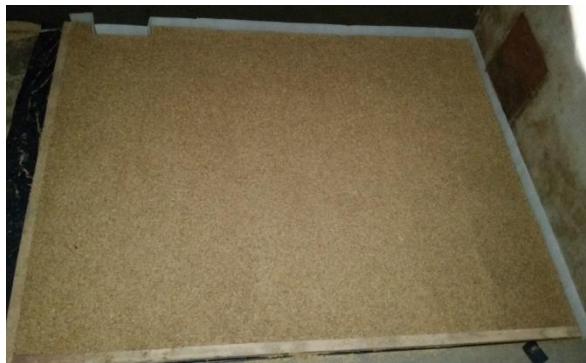
Figura 3. 23 Piso con aislamiento de aglomerado de cascarilla de arroz
