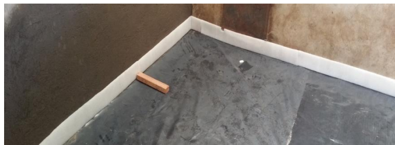
Figura 3. 21 Instalación de banda perimetral
