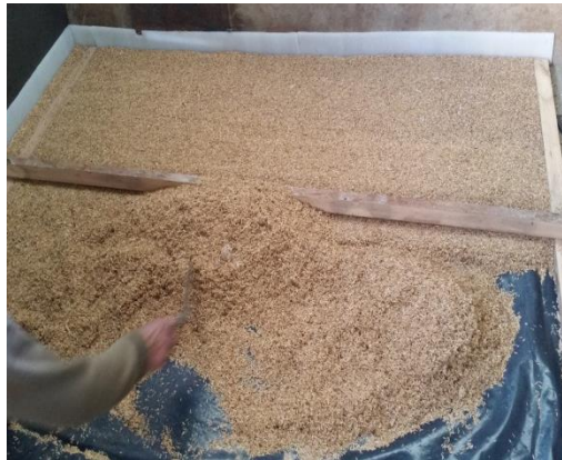
Figura 3. 22 Instalación del aislante
