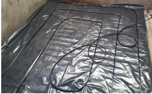
Figura 3. 28 Tendido de red de tuberías
