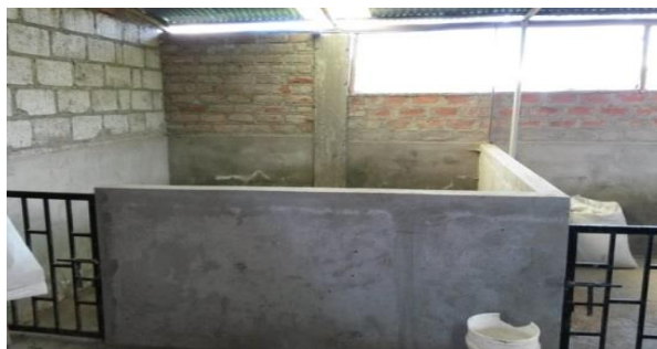
Figura 1. 5 Corral para pruebas de suelo radiante
