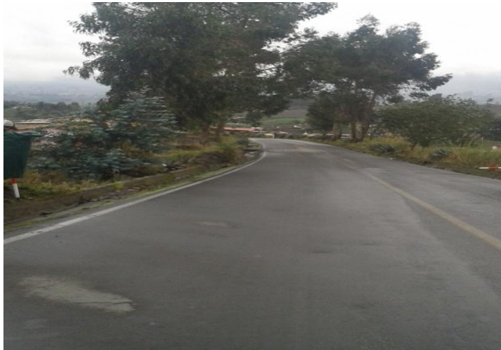
Fotografía N°1. Vía A asfaltada
