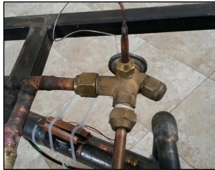
Gráfico N° 5. Válvula de expansión termostática. Fuente: Autor
